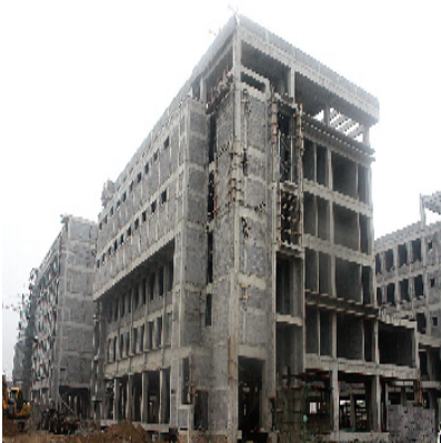
建设中的虞城县人民医院门诊行政楼
