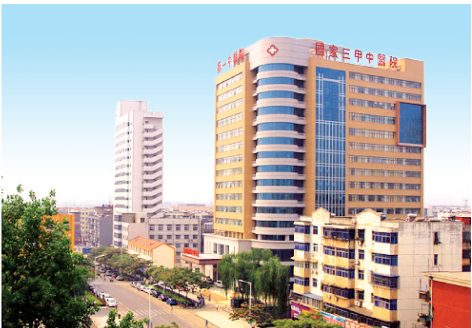
北院新建的综合病房楼
