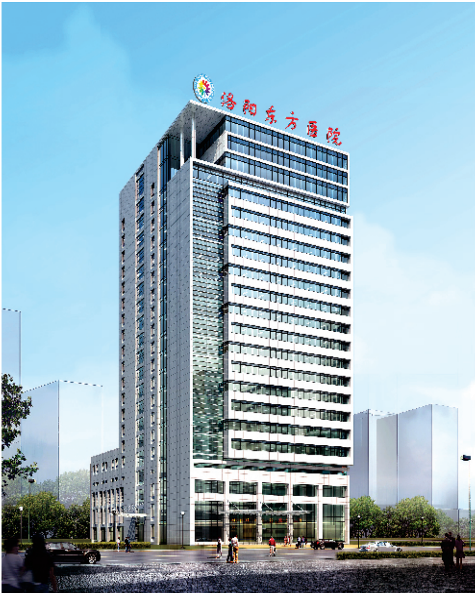
即将投用的新综合病房楼
