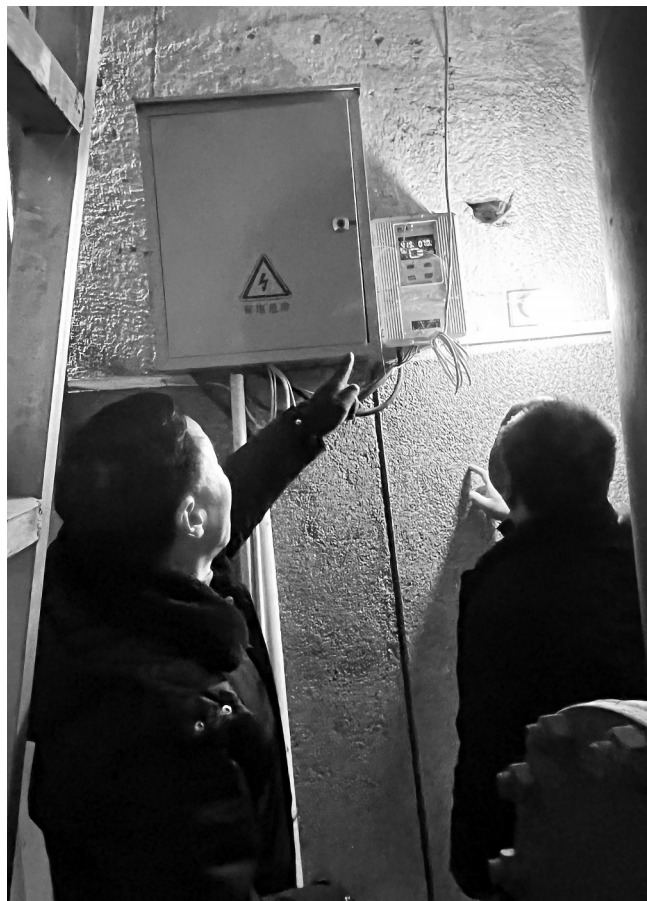
1月22日,在内乡县王店镇卫生院,内乡县卫生健康委工作人员检查配电房。当天,内乡县卫生健康委工作人员到王店镇卫生院督导安全生产及消防工作,彻底排查医疗机构安全生产隐患,坚决遏制安全生产事故的发生。
